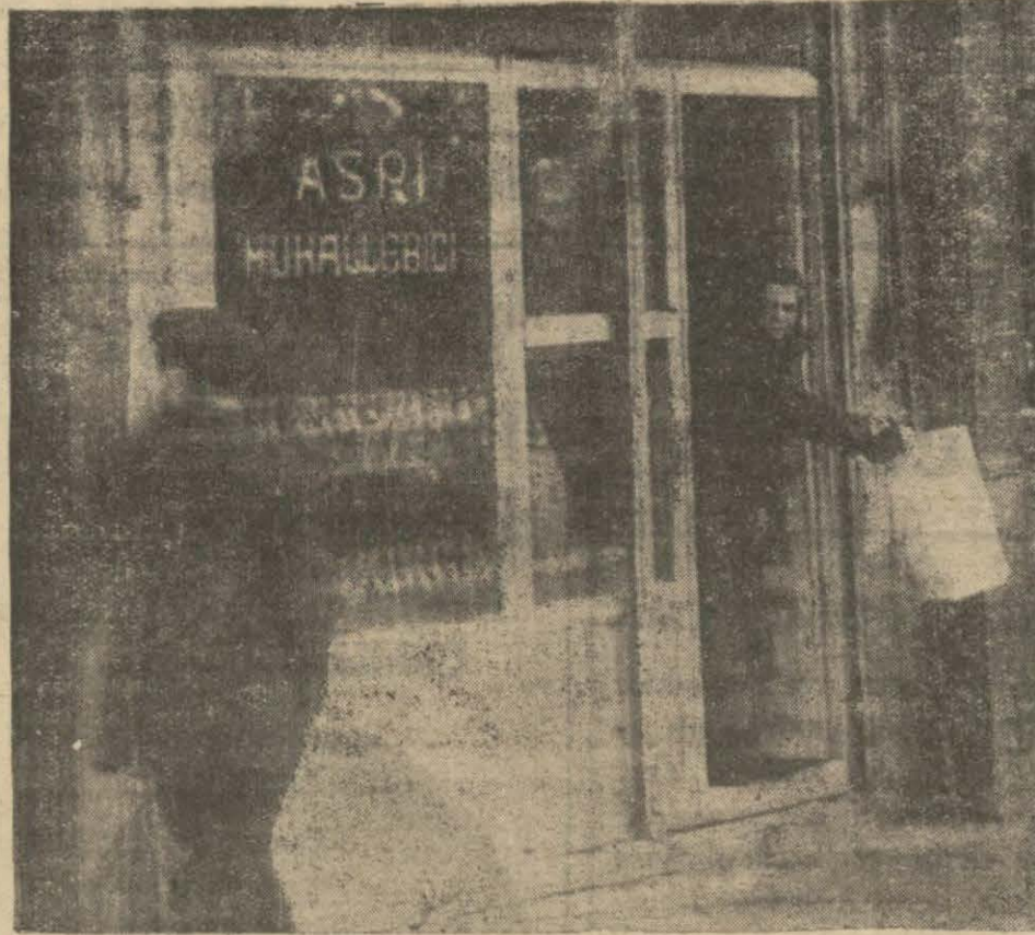
Asri mahallebici dükkânı
